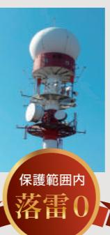
スペイン気象庁の気象レーダーに設置。バスク地方は雷の発生率が高い地域として知られています。dinnteco-100plus設置直前にはレーダーへの直撃雷があり、実証実験期間中も2km圏内で96回の落雷がありましたが、保護範囲内への落雷は、冬季雷含め0件となりました。
